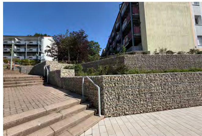
Neue Gabionenwand in der Plauener Straße.
