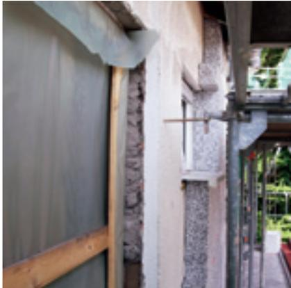
Wärmedämmung von 10 cm bis 14 cm.
