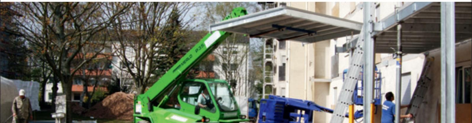
Die alten Balkone wurden entfernt und die neuen größeren Balkone angebracht. Gleichzeitig wurden durch die neuen Balkone der zweite Rettungsweg hergestellt.
