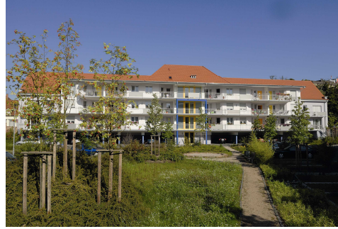
Das Assisted Living-Projekt in der Albert-Schweitzer-Straße 41/ 41a
